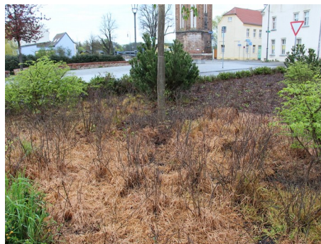
Bild 14: Sogar Baumscheiben, für die es keine Nutzungsanforderung gibt, werden vollständig mit Betonplatten und Splitt versiegelt
